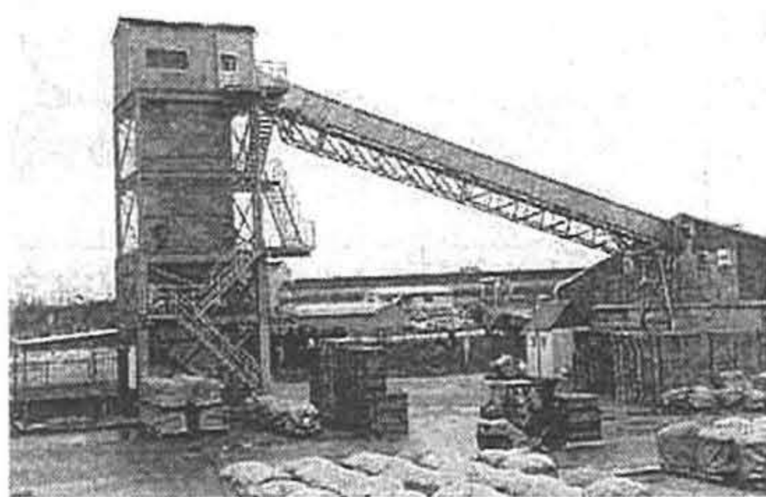
トラックにじか積みする貯塩バンカー設備
