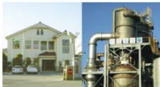
写真左：西浜塩業組合時代からの事務所棟
